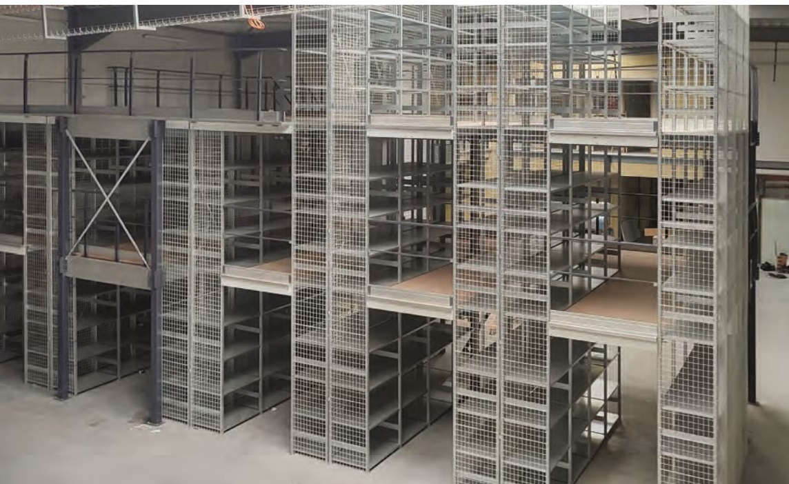
Espace de stockage structuré sur 4 étages, pour réduire au maximum l'encombrement au sol. Gain considérable du coût au m 2 (DDI)
