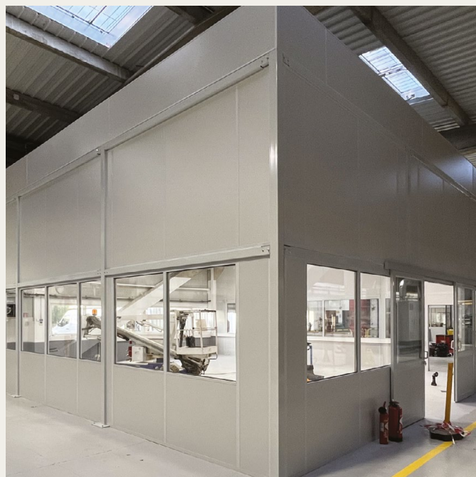
Conception et réalisation d'une cabine autoportante, ventilée et climatisée, d'une taille de 10 m (L) x 11 m (l) x 4,5 m (H)
