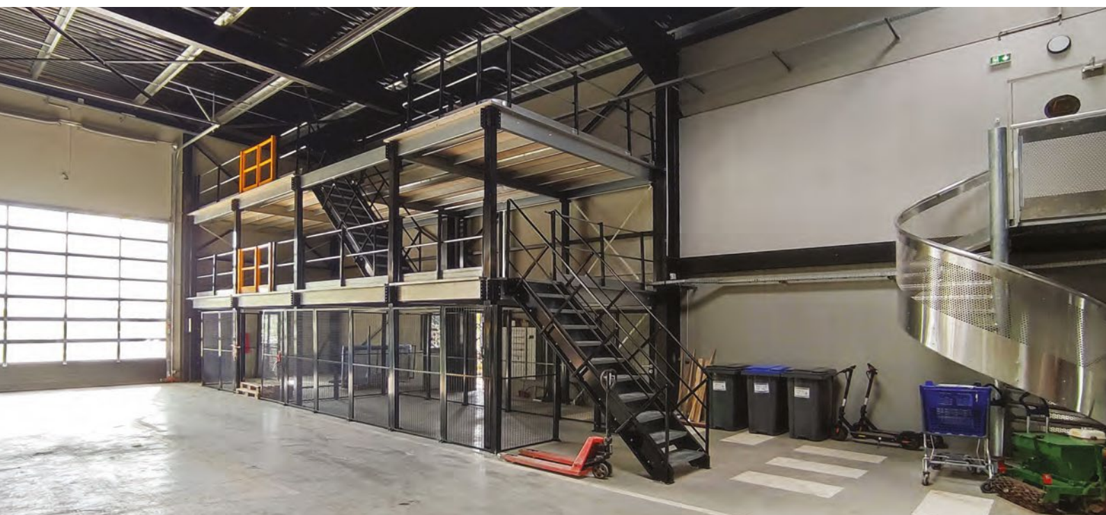
Limitation des accès à l'entrepôt par un système de cloisons avec une porte coulissante pour le passage des palettes (DDI Rayonnage)
