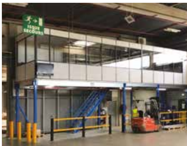
Espace de bureaux installé sur une mezzanine dans un entrepôt logistique pour augmenter la surface au sol. La structure de la plateforme est équipée de barrières à mémoire de forme et de protections de poteaux pour sécuriser les accès (GBG Concept)
