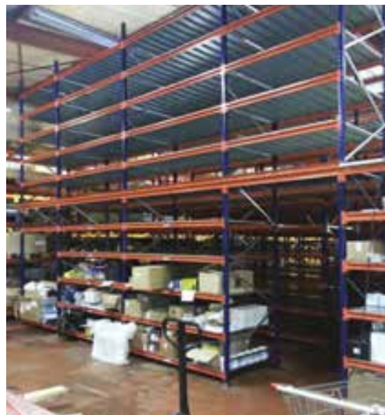
Rayonnages ACTI-RACK installés sur toute la hauteur du bâtiment, avec plancher en aggloméré standard et platelages métalliques pour sécuriser les allées de passage sur les niveaux de stockage (Classotech)
