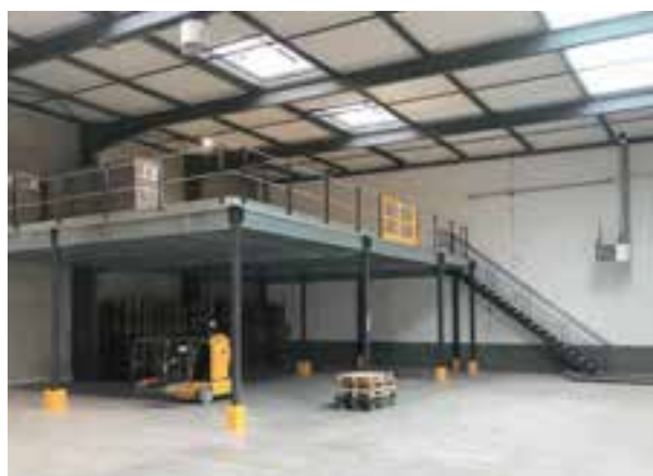
Redoublement d'une surface de stockage avec une plateforme équipée d'une rambarde et d'un portillon à retour automatique pour le chargement/déchargement de palettes à l'étage en toute sécurité (Araydis)
