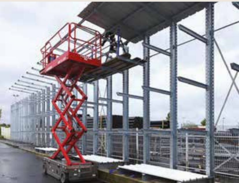
Installation en extérieur en cours de montage, avec colonnes et bras en acier galvanisé à chaud anticorrosion (GBG Concept)
