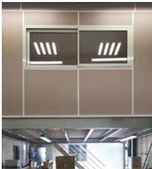
Installation d'un bureau au-dessus d'un atelier de production pour répondre à un accroissement d'activité sans devoir déménager (Absices)
