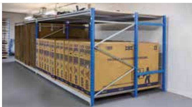
Rayonnages grande profondeur pour l'entreposage de colis volumineux (Avas Equipement)
