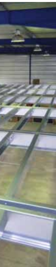
Plateforme en cours d'installation dans un atelier de fabrication, avec alignement du plancher de la mezzanine et celui du bâtiment (Marc Van Ackere)
