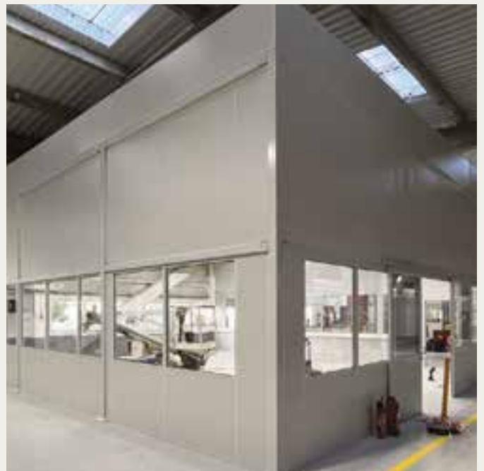
Conception et réalisation d'une cabine autoportante, ventilée et climatisée, d'une taille de 10 m (L) x 11 m (l) x 4,5 m (H)
