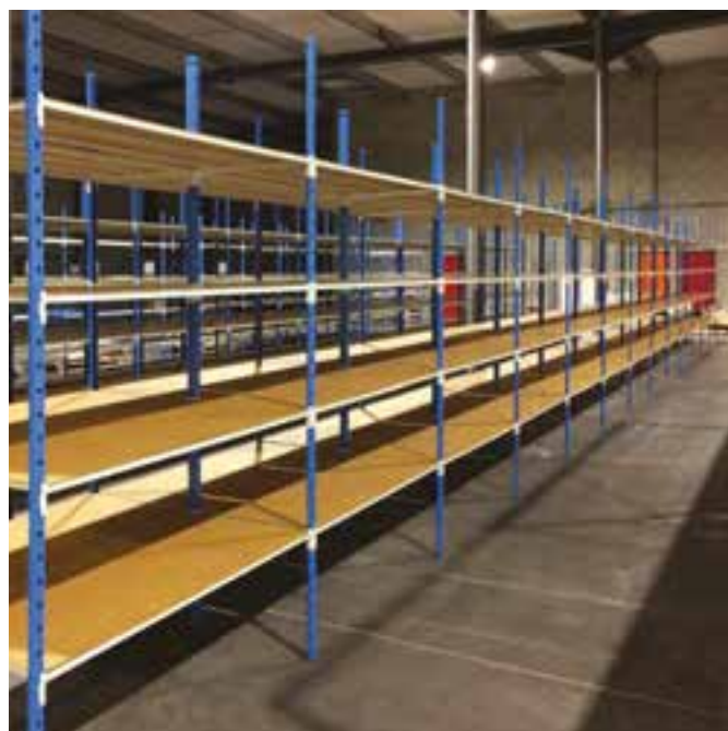
Installations de rangements en longueur sur plusieurs rangées pour le stockage de cartons volumineux de faible charge (Poitou Rayonnage)
