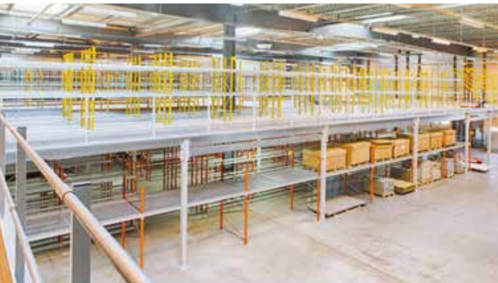
Aménagement complet d'un entrepôt logistique de pièces détachées automobiles d'une surface de 4 000 m 2 , avec des rayonnages installés sur et sous la plateforme (Spade Equipement)
