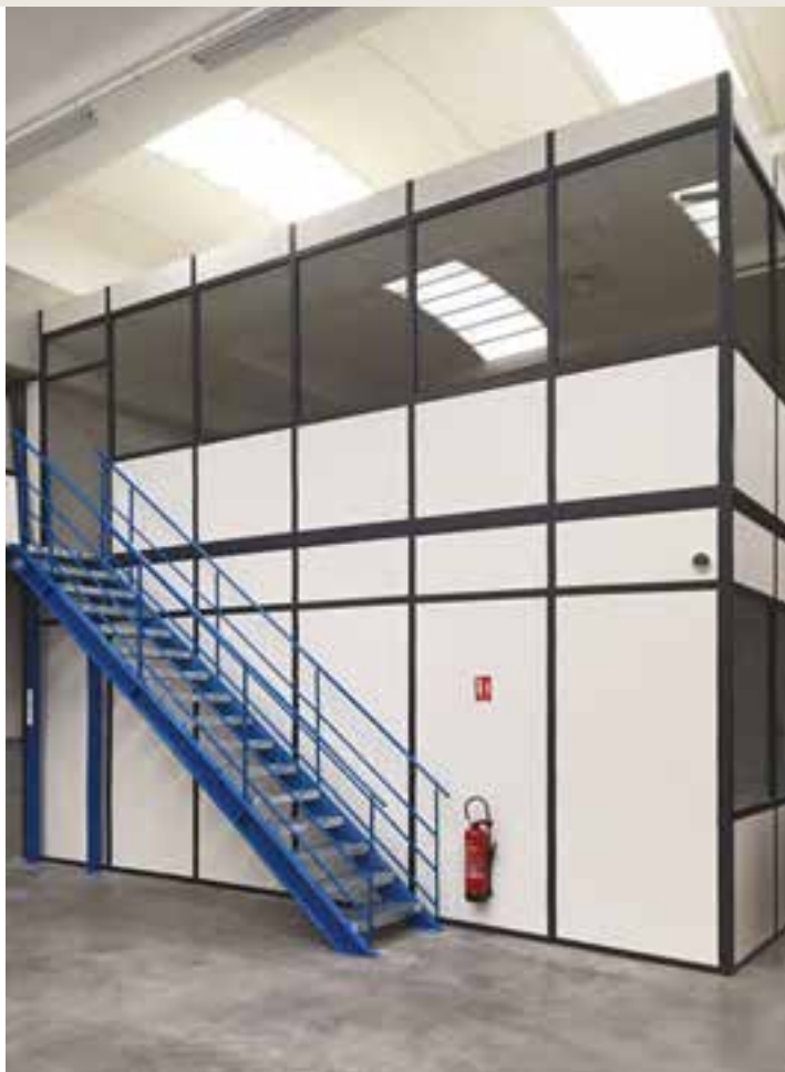
Bureaux et espace collectif organisés sur deux étages (Avas Equipement)
