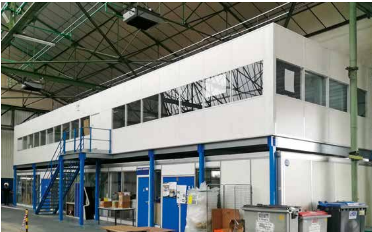
Exploitation de la hauteur d'un bâtiment pour l'ajout de bureaux sur une plateforme, au-dessus de bureaux existants (Merial Bordeaux)
